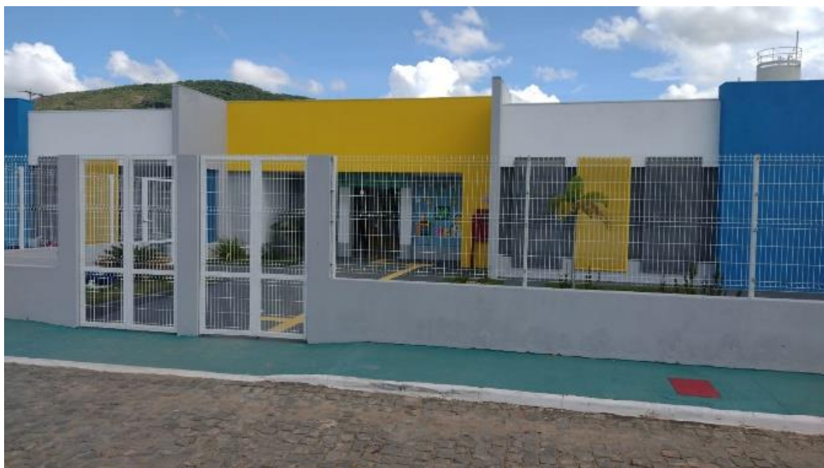
FIGURA 07: Fachada da Creche Municipal Antônio Edson Sampaio
