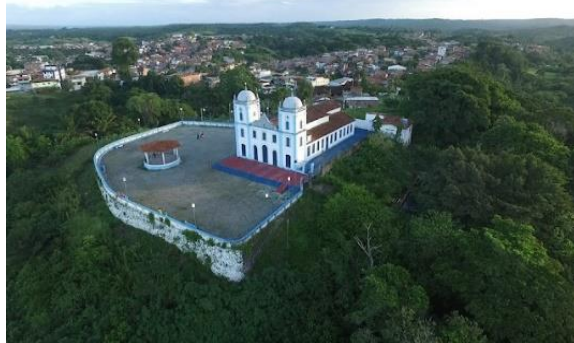
Figura 2 – Igreja Nossa Senhora do Amparo, Valença
