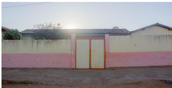
ESCOLA PRUDÊNCIO RODRIGUES SOBRINHO - ENSINO INFANTIL E FUNDAMENTAL I (POVOADO DE AROEIRAS) FOTO: JORGE PHOTOS
