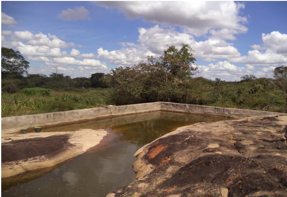
Fotografia 8 - Tanque de Pedra
