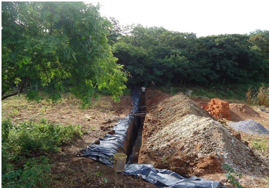
Fotografia 7 - Barragem subterrânea em construção
