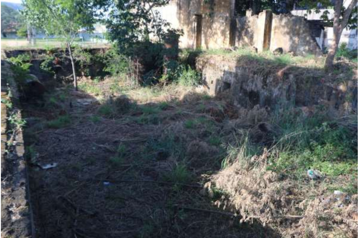
Imagem 60: Vista lateral da zona de evisceração e saponificação. Escadas de acesso completamente arruinadas. Dimensão: 155,76 m 2 .
