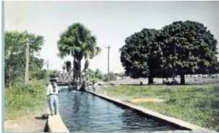
Imagem 9: Vista do Canal do Rego. Canal artificial criado para alimentar a Usina Hidrelétrica Rocha.
