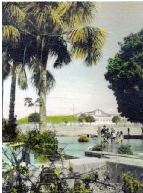
Imagem 17: Banhistas em uso do Canal do Rego. Matadouro ao fundo.
