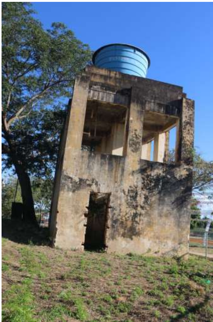
Imagem 64: Vista frontal do banheiro dos funcionários. Dimensão: 51,26 m 2 .
