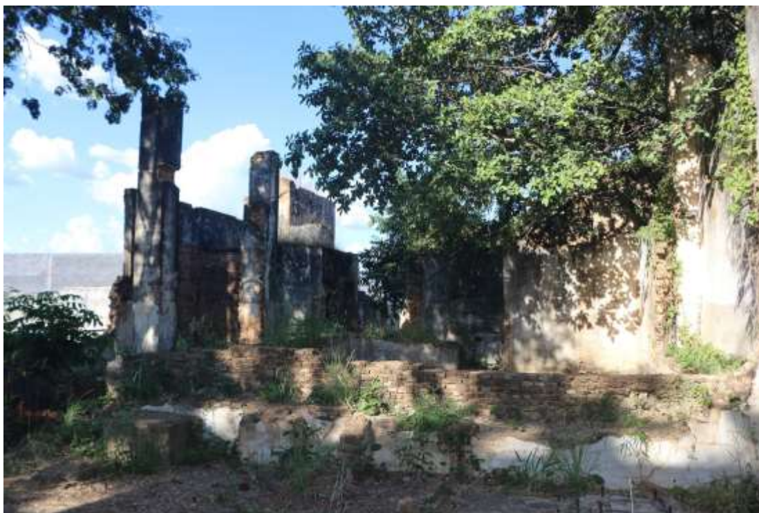
Imagem 57: Restos das câmaras frigoríficas. Dimensão: 42,88 m 2 .
