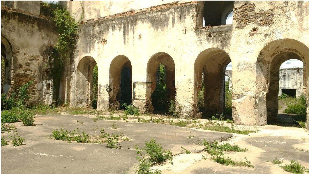
Figura 6 – Vista do interior do quadrante central das ruínas
