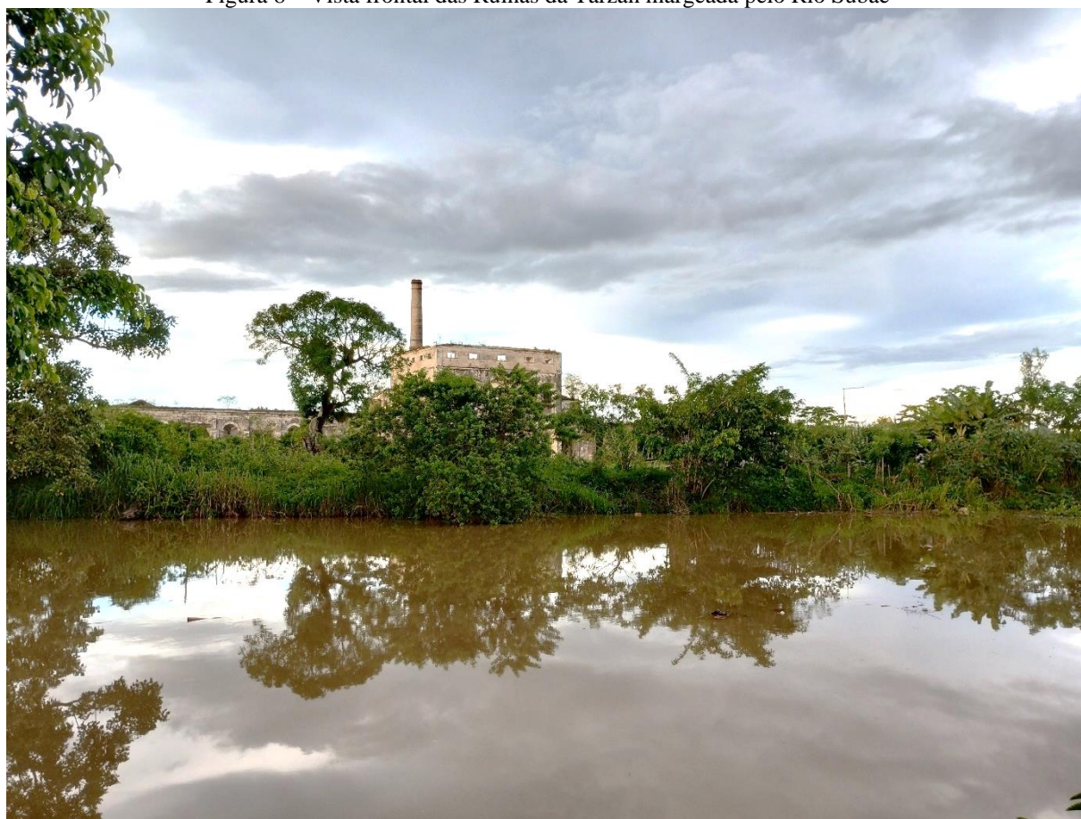
Figura 8 – Vista frontal das Ruínas da Tarzan margeada pelo Rio Subaé
