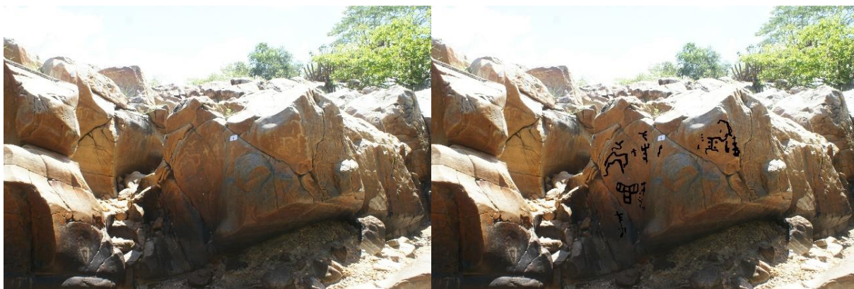
Figura 120 – Visão geral do suporte 1 do setor 3/margem esquerda
