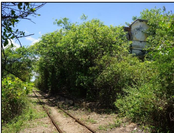
Imagem 11: Estação Ferroviária de Pombal.
