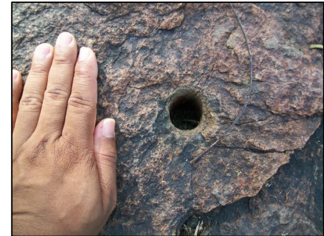
Imagem 54: perfuração pneumática para explosivos.
