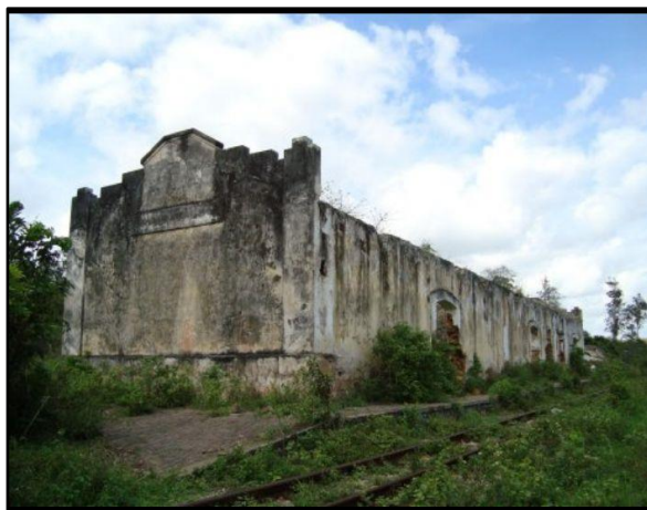
Imagem 10: Estação Ferroviária de Pombal.
