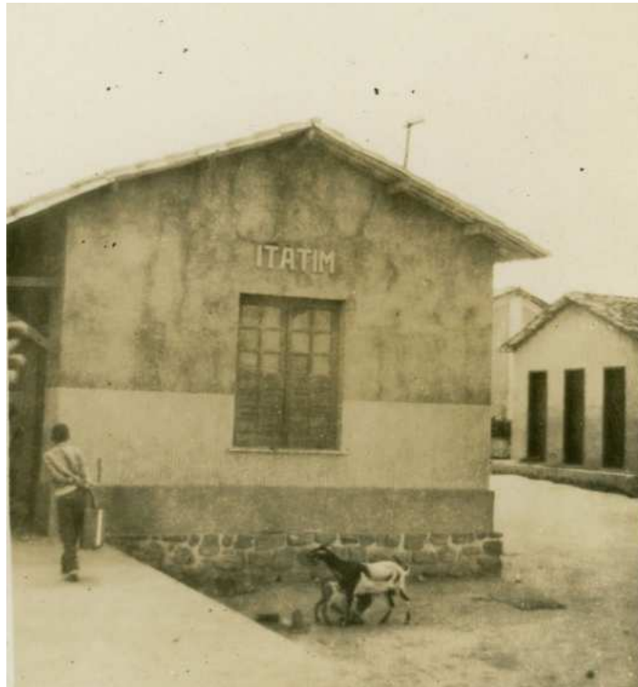
Figura 26. Estação ferroviária de Itatim, 1950.
