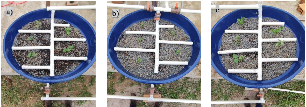
Figura 8. Leito filtrante e local onde foi instalado o último piezômetro (a); Leito totalmente preenchido e com a camada superficial de brita (b).
