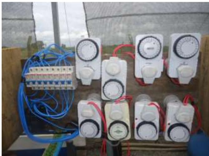
**Figura 2.** Conjunto de temporizadores e disjuntores usados para distribuição da energia elétrica e controle das frequências de recirculação da solução nutritiva.
