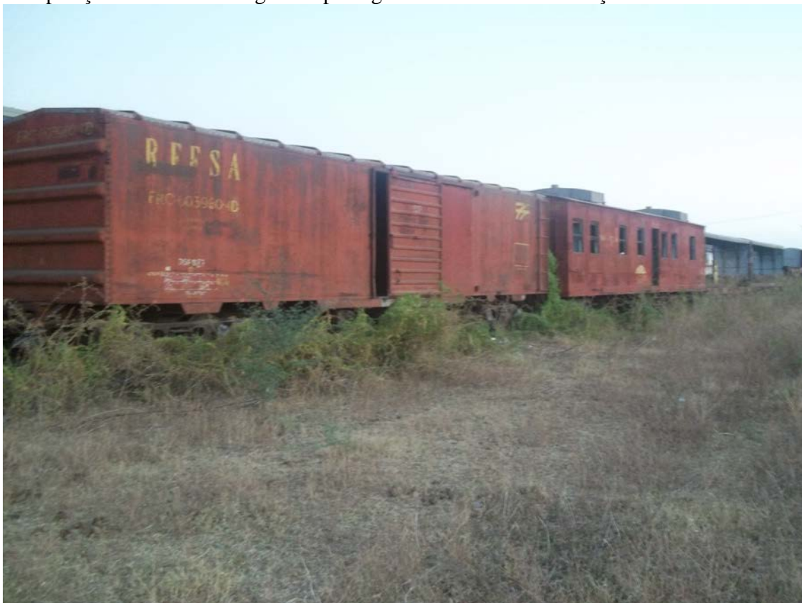
Composição de Carro de carga e de passageiros deteriorados - Estação de Montes Azul
