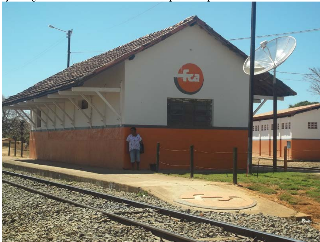
Estação Engenheiro Zander – Sede do Município de Capitão Enéas
