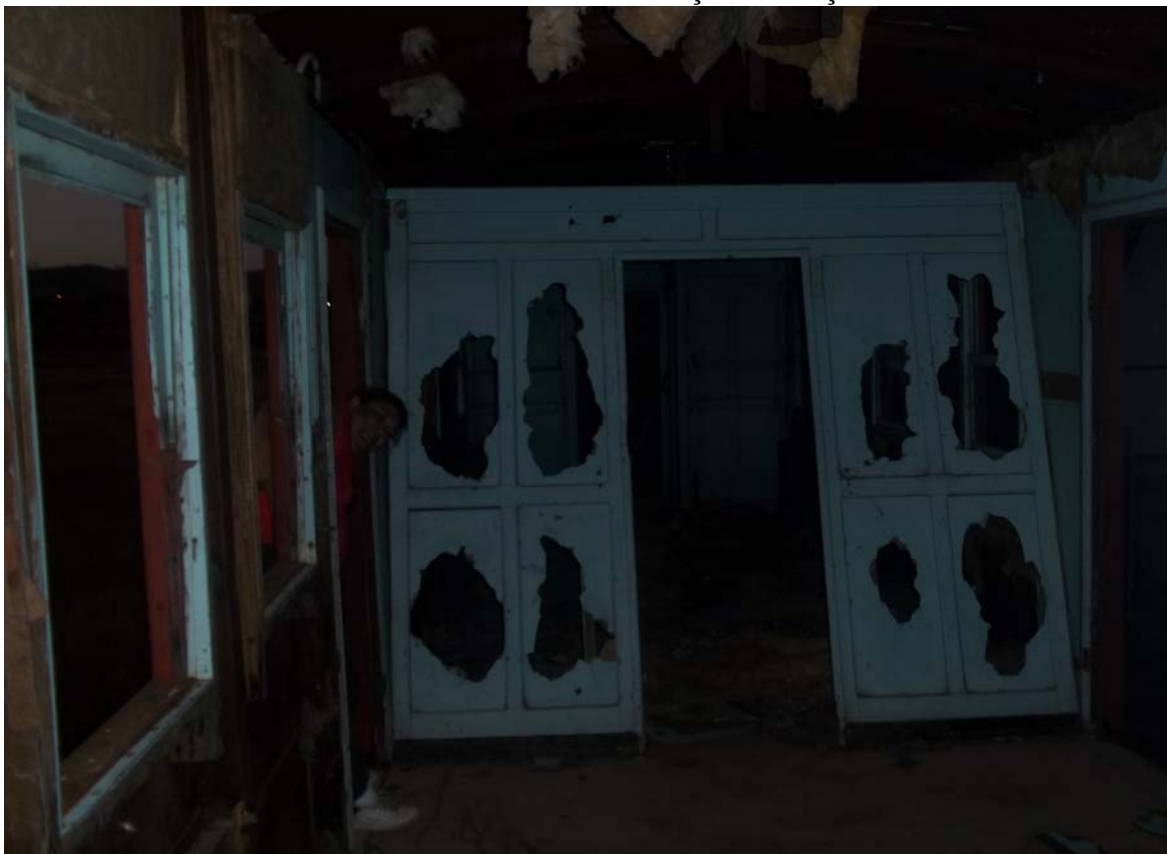
Parte interna do carro de Pronto Socorro em deterioração - Estação de Monte Azul
