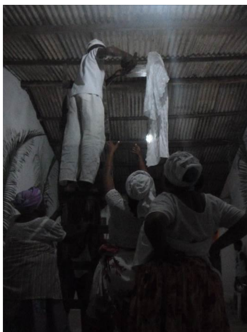
Figura 28. Ogã arrumando a cumeeira do barracão.
