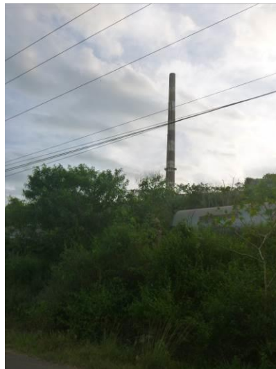
Figura 34. Torre da antiga COBRAC vista próxima a Toca do Jaguaraci.
