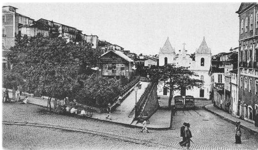
Figura 2 - Igreja da Barroquinha em 1904, vista da Praça Castro Alves. Fonte: Não divulgada - Imagem retirada do Guia Geográfico de Salvador [versão online].
