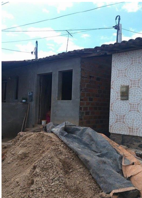
Figura 6- Fachada da casa de trabalho a esquerda, a direita pode-se notar uma residência. Fonte: Foto da autora (2016).
