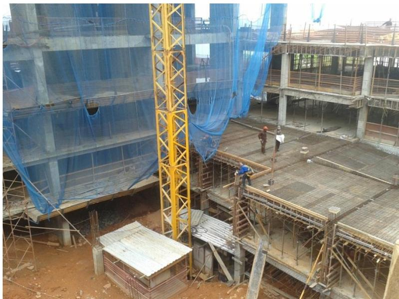
Figura 8 - Imagem captada durante o passeio na obra, trabalhadores preparando para concretar rampa de acesso a garagem. Fonte: Zelivaldo Falcão, 2016.
