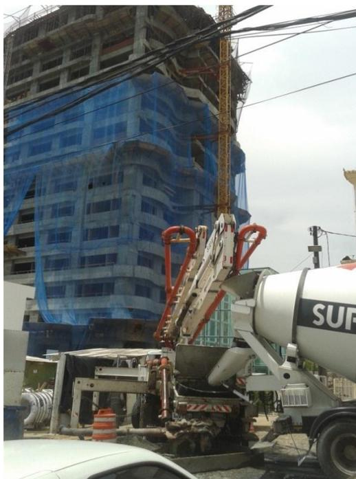
Figura 4 - Bombeamento do concreto para a obra, futura Mansão ao fundo. Fonte: Zelivaldo Falcão, 2016.
