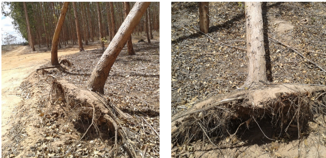
Figura 1: Detalhe da horizontalização das raízes e tombamento de plantas de eucalipto na área de estudo
