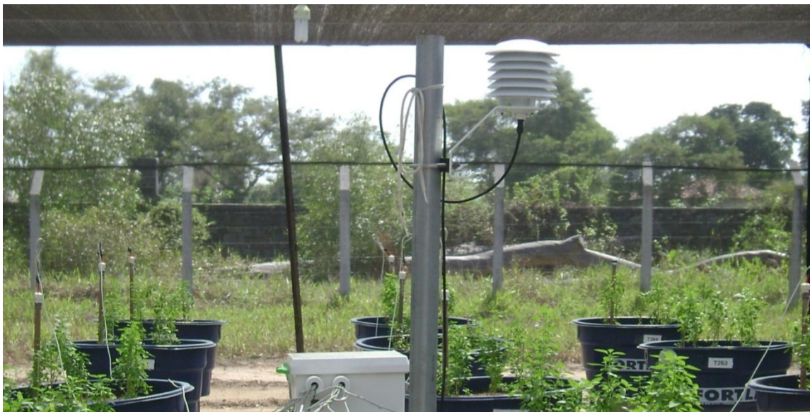
Figura 2. Sensor instalado no interior da casa de vegetação. Fonte: SUZART (2013)
