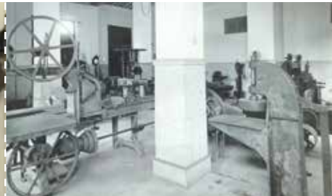
Gabinete de mecânica - Monte Serrat | Mechanics room - Monte Serrat
