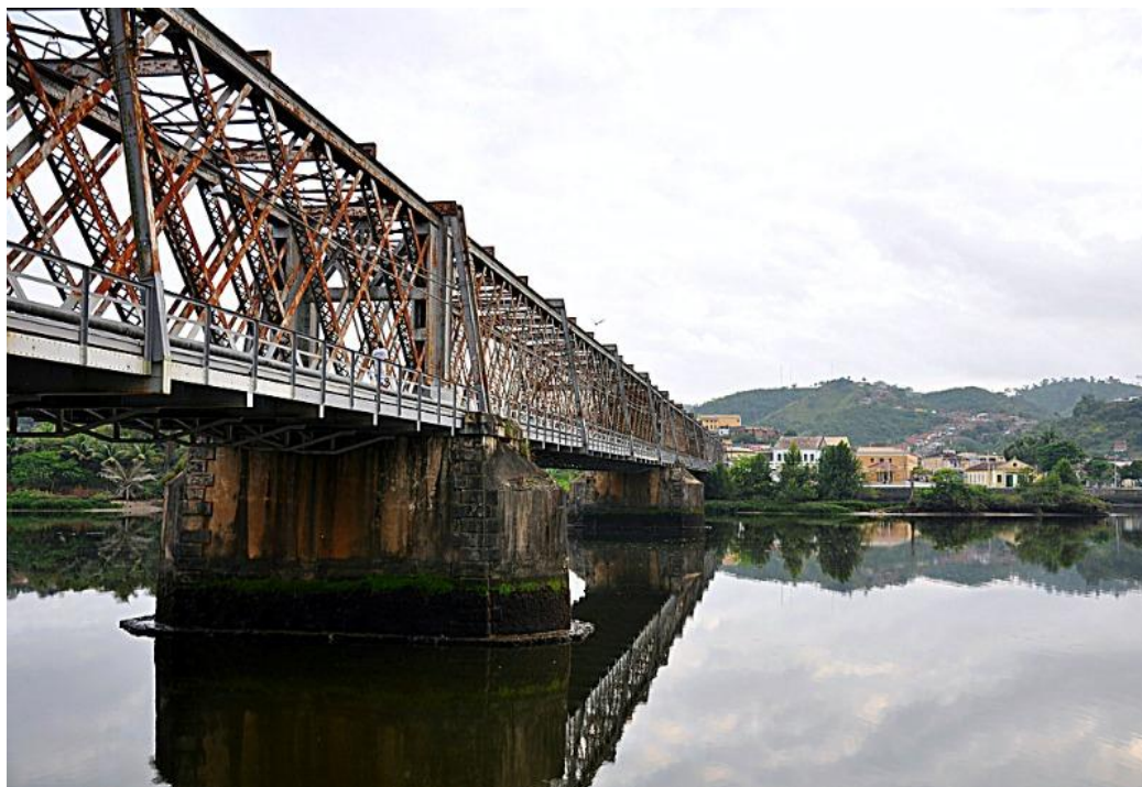
Figura 13 – Foto da Ponte D. Pedro II Fonte: CAMINHO DE PEDRO, 2013.
