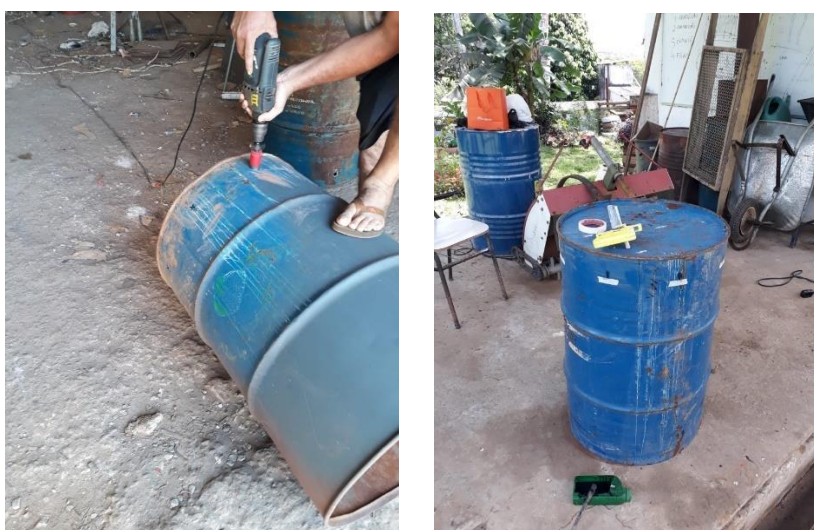
Figura 9: Adaptações em andamento nas novas câmaras de combustão.
