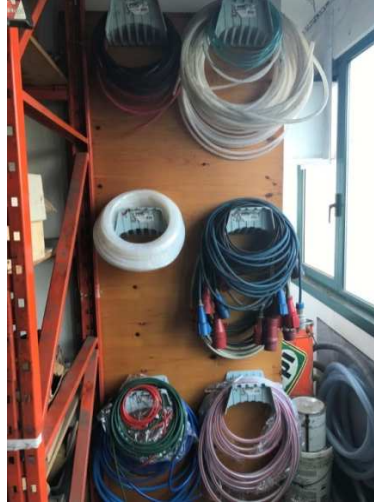
Figura 20. Organização tubos e fios na oficina.
