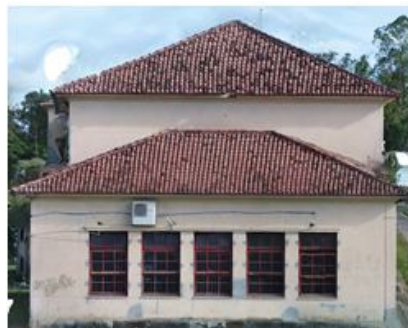
Figura 5 – Fachada lateral esquerda.
