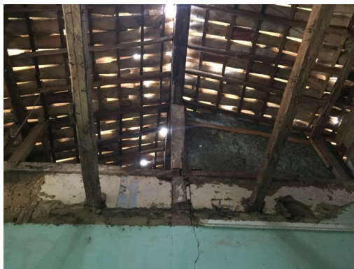
Figura 14 – Sistema de caibro armado, sem tesouras.
