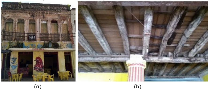
Figura 4 – Fachada frontal (a) e detalhe construtivo (b).
