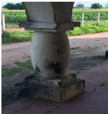
Figura 8 – Detalhe do fuste, base e plinto da coluna.
