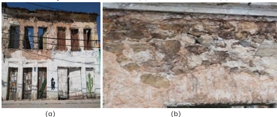
Figuras 3 - Fachada frontal (a) e detalhe construtivo (b).
