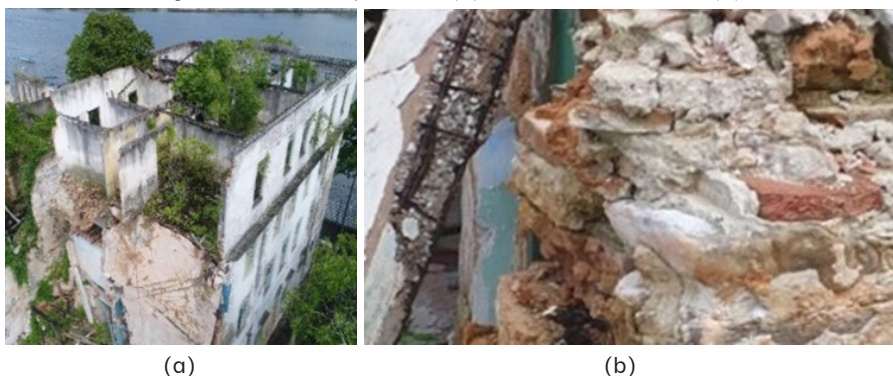
Figura 5 – Fachada posterior (a) e detalhe construtivo (b).
