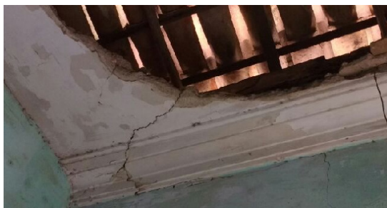
Figura 13 – Detalhe do forro em estuque.
