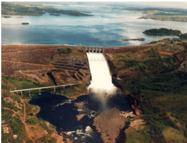
Figura 3 – Vista da barragem Pedra do Cavalo.
