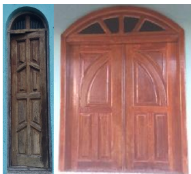
Figura 3. Janelas da residência 1.
