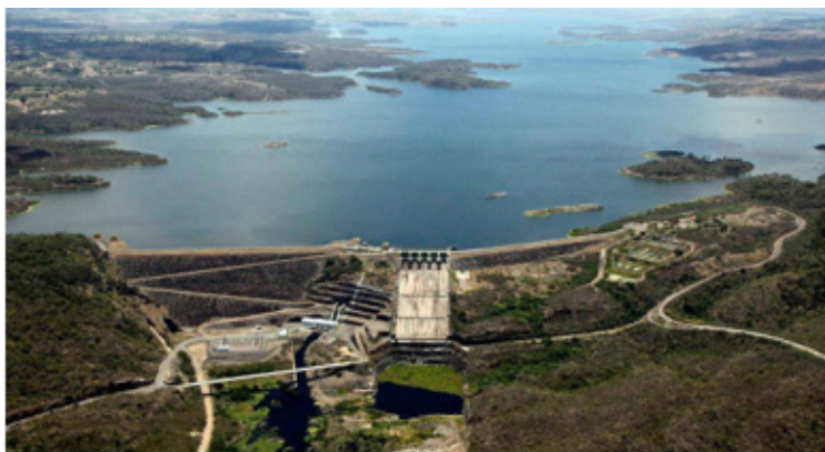
Figura 1 - Usina Hidrelétrica de Pedra do Cavalo no rio Paraguaçu, divisa dos municípios de São Félix e Cachoeira, no recôncavo da Bahia.
