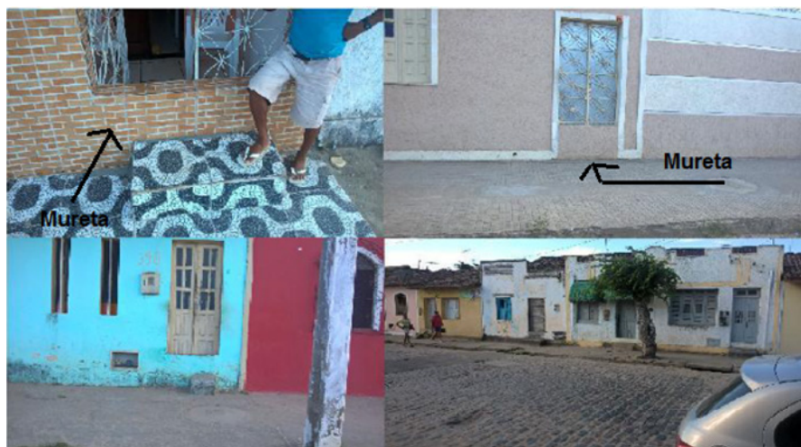
Figura 8. – Residências com muretas contra inundação (rua Dr. Lauro Passos).
