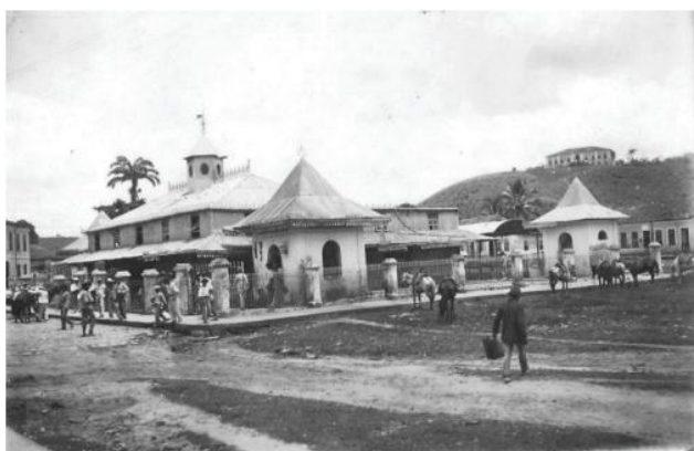
Imagem 1 - Mercado Municipal de Santo Amaro construído em 1893.
