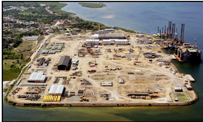
Figura 06: Instalações do Estaleiro São Roque do Paraguaçu
