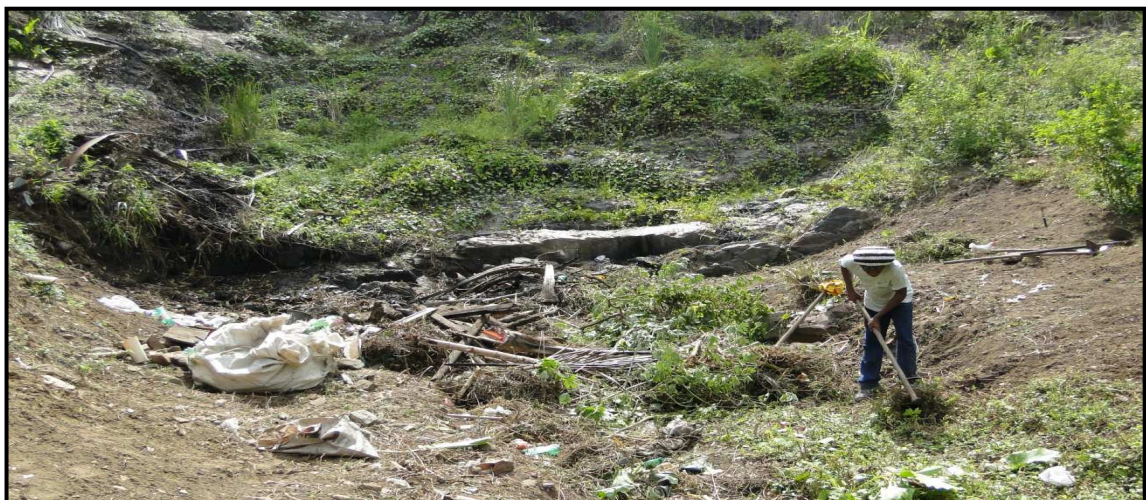
Figura 09: Limpeza de um dos afluentes do rio Paraguaçu
