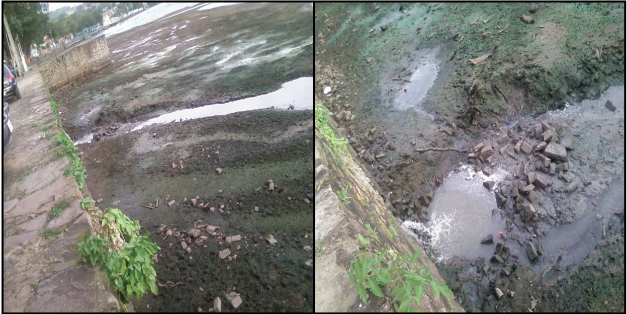
Figura 13: Rede de esgoto sendo lançada no rio Paraguaçu
