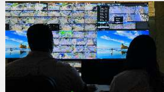
Sistema de videomonitoramento
