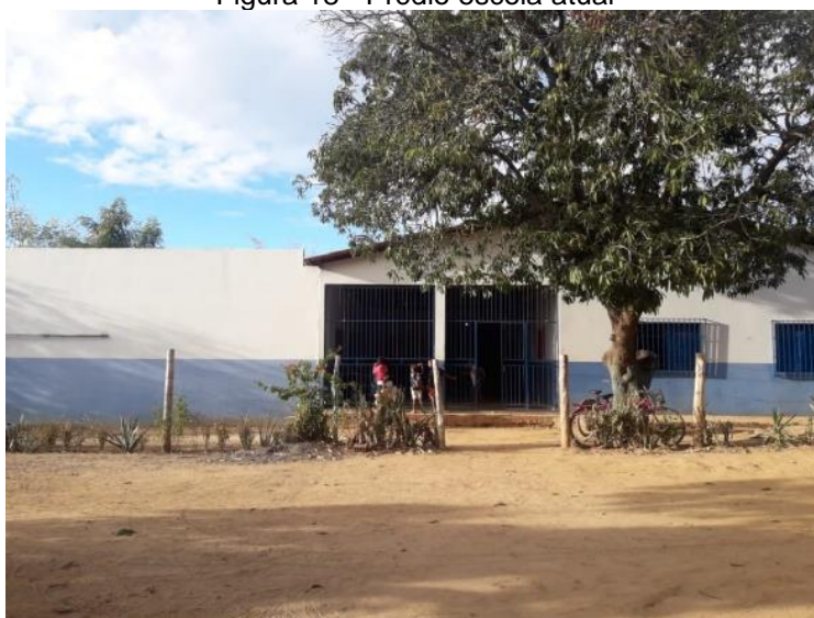
Figura 18 - Prédio escola atual
