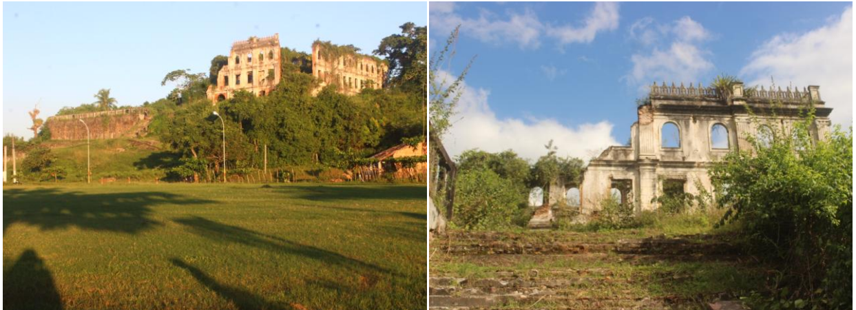
Figuras 4 e 5: As ruínas da Escola Agrícola de São Bento das Lages.
