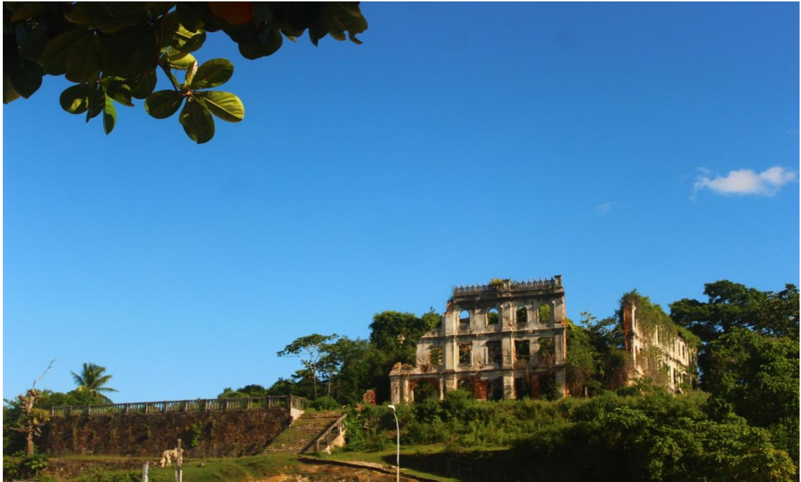
Figura 2: As ruínas da Escola Agrícola de São Bento das Lages.
