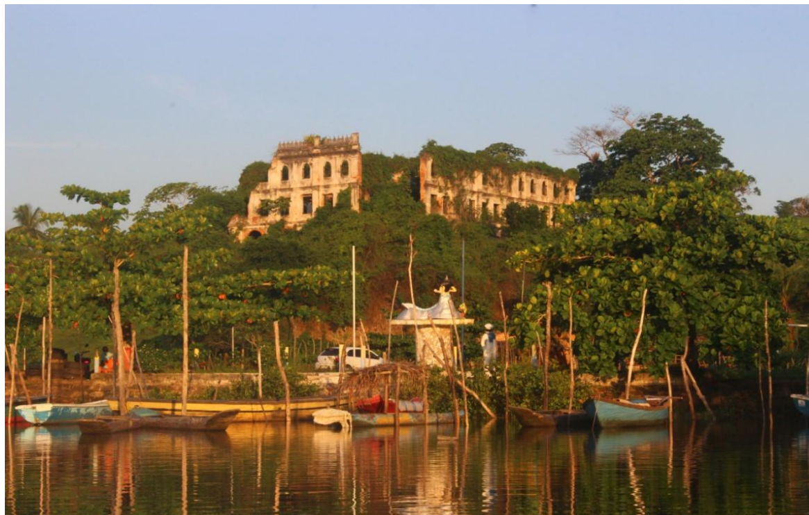
Figura 91: As ruínas da Escola Agrícola de São Bento das Lages.
