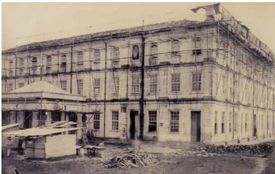
Figura 34: Fotografia em preto e branco da reforma do edifício principal da Escola Agrícola da Bahia, em São Bento das Lages, São Francisco do Conde (BA).
