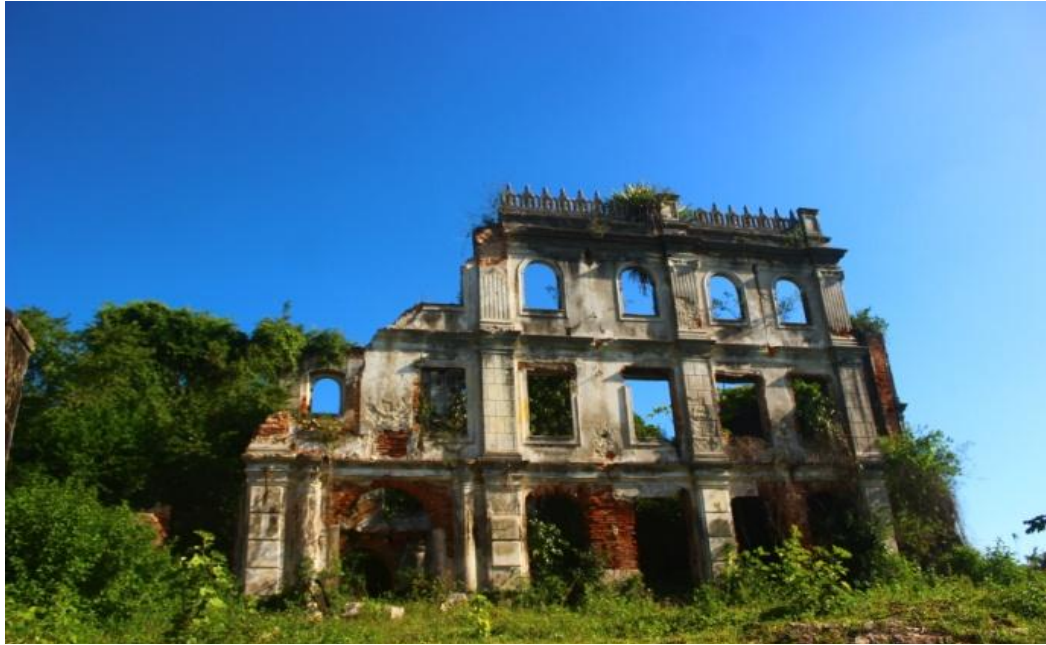
Figura 24: As ruínas da Escola Agrícola de São Bento das Lages.
