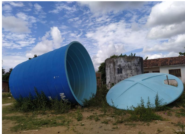
Imagem 8: Tanque de água abandonado
