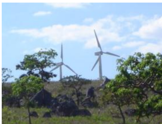
Usina eólica da CEMIG no Morro do Camelinho - Gouveia
