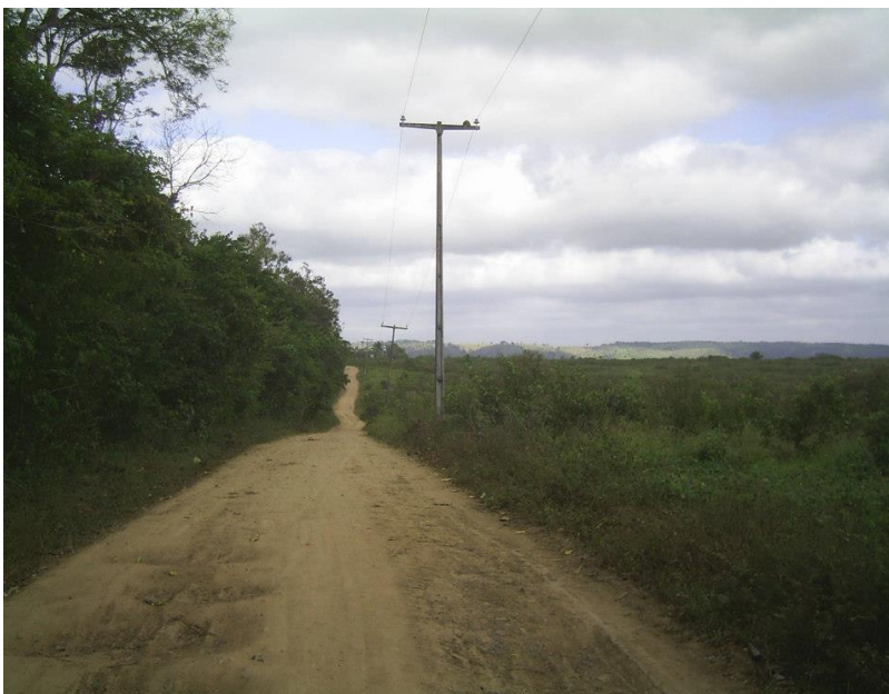
Estrada que liga a pista de asfalto à comunidade do Kaonge
