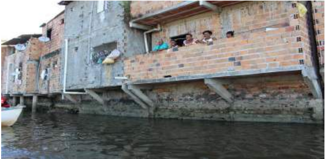
Figura 15. Vista do Fundo da Rua João Soldado, visão para o Rio Subáe. Foto: Maria das Candeias, 2014.
