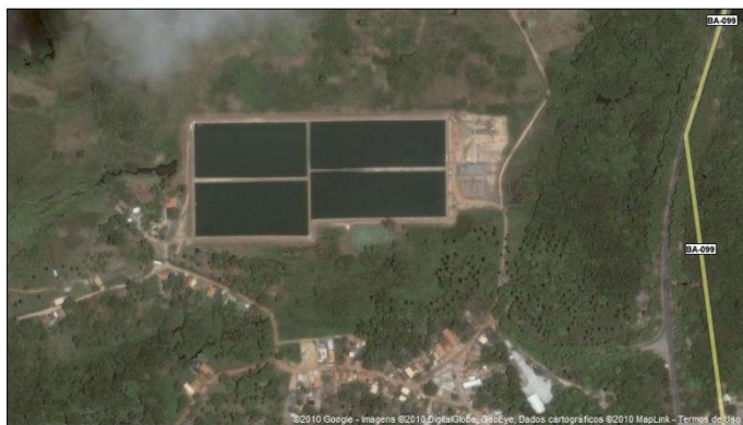
Figura 1. Vista aérea da Estação de Tratamento de Esgoto de Sauípe-BA.
