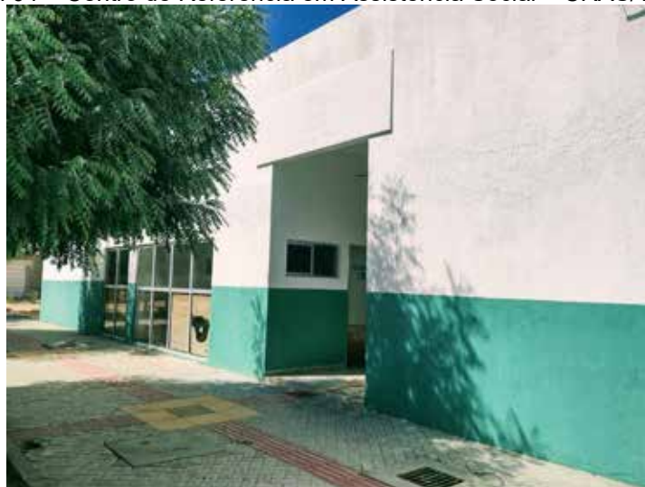
Figura 04 – Centro de Referência em Assistência Social – CRAS/Tabuleiro
