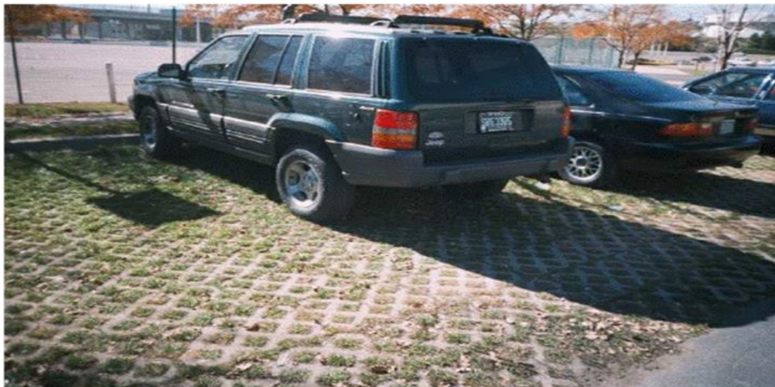
Figura 2 - Pavimento permeável (área de estacionamento)
