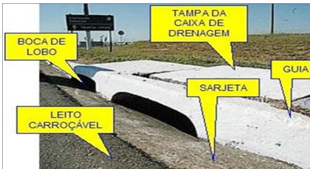
Figura 7 – Elementos de uma rede de Microdrenagem
