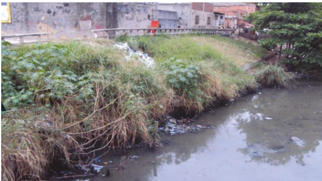
Figura 10 – Macrodrenagem (canal natural na macrodrenagem urbana)
