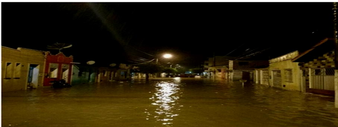
Foto 8 - Alagamentos recentes na Rua Manoel Vilaboim
