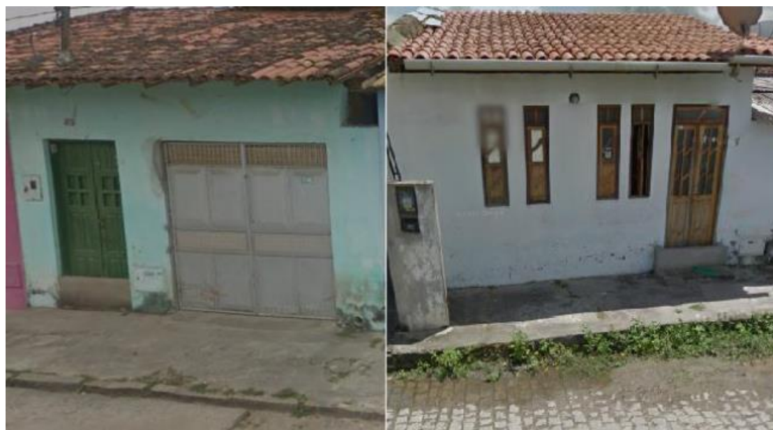
Foto 3b - Residências com muretas contra inundação na rua Dr. Lauro Passos
