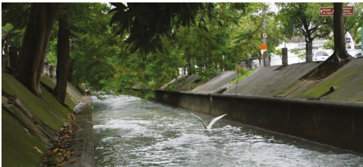
Figura 12 – Macro drenagem (rio artificial, canalizado e revestido)
