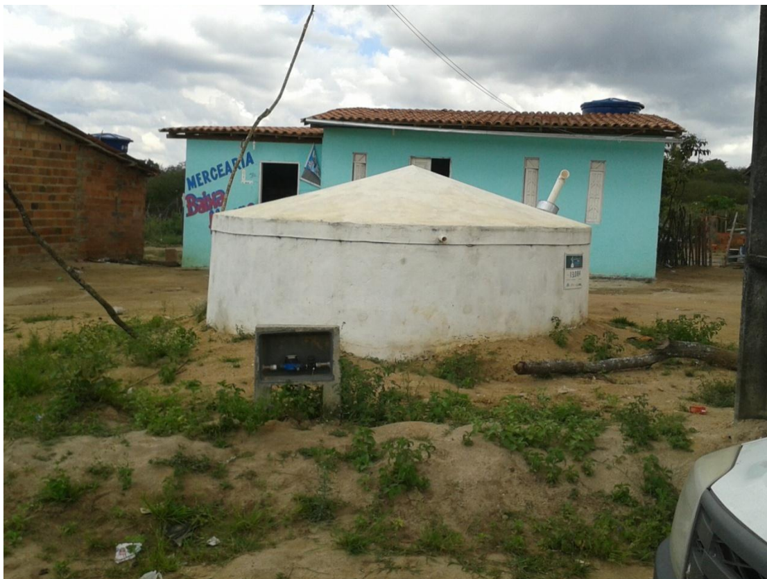
Figura 106 – Casa ligada à rede de distribuição da Embasa e com cisterna
