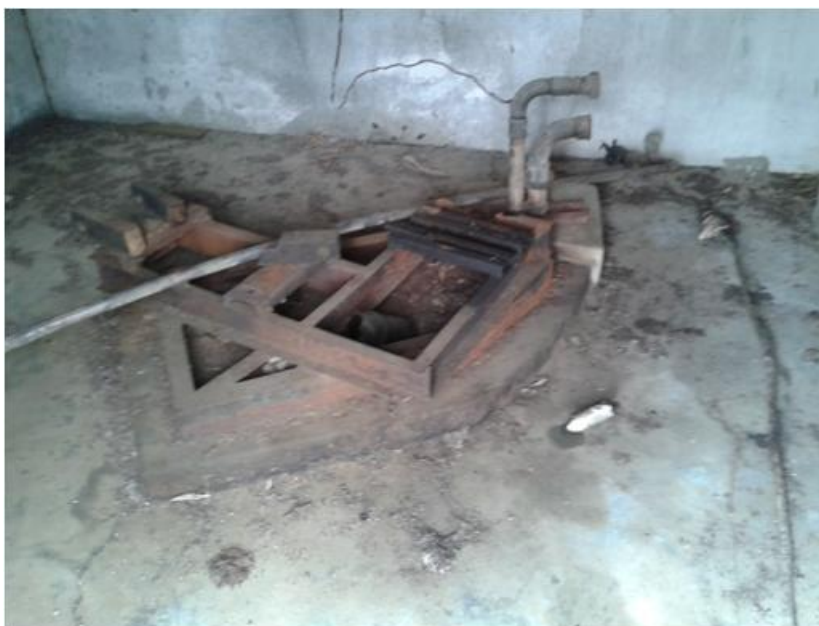
Figura 102 – Poço desativado do povoado do Rumo
