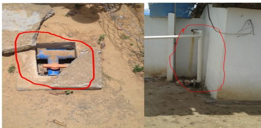
Figura 101 – Dispositivos descarte primeiras águas de chuva
