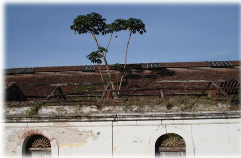
Figura 12: Imagem externa telhado lado esquerdo Foto: Rodrigo Valverde
