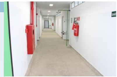
Corredor do Pavilhão de Laboratórios
